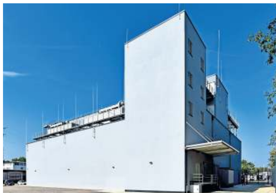
Außen unscheinbar, innen hochmodern: das Rechenzentrum in Karlsruhe
